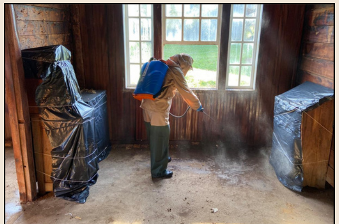
Vista da parte interna da tipografia antes da recuperação e processo de sanitização das superfícies onde havia dejetos de morcegos, 2022
